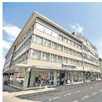
Das Gebäude an der Kasinostrasse ist sanierungsbedürftig.
